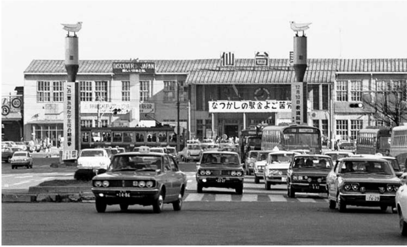
仙台駅 旧駅舎
